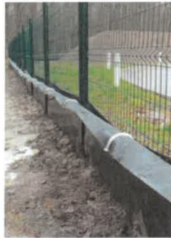
Figure 5 : bêche enterrée avec bavolet (Source : Eco sphère)
