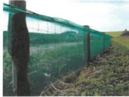
Figure 3 : Filet enterré doublé par un grillage à mouton avec bavolet sur le chantier de la RN4 à Herming (Source : © A. Morand, Cerema Est)
